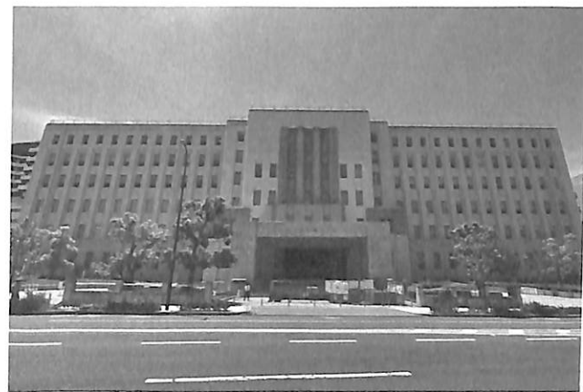
大阪府本庁舎
