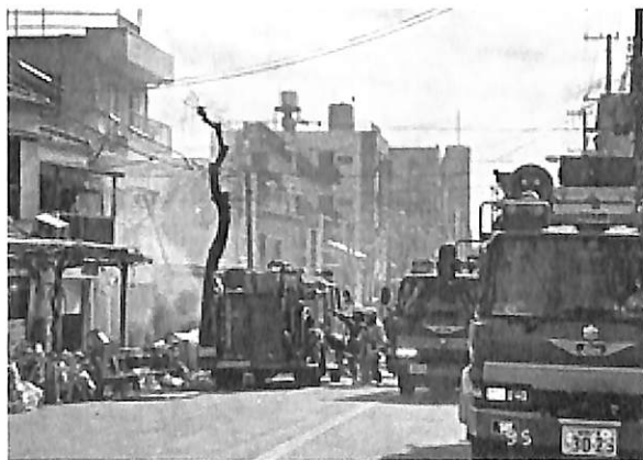
23年前の通電火災の現場(関電・神戸市提供)
